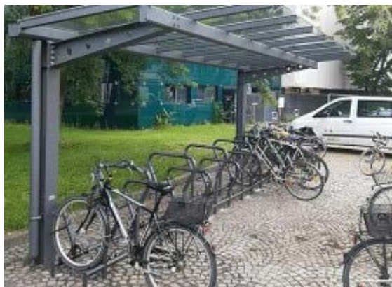
An der Oper sind Fahrradabstellanlage und -überdachung bereits installiert © Foto: Bundesstadt Bonn
