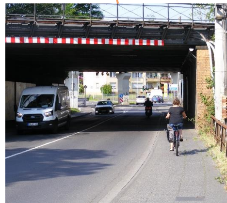
Grenzwertig ist der Zweirichtungs-Fuß- und Radweg im Bereich der Brückenunterführung.
