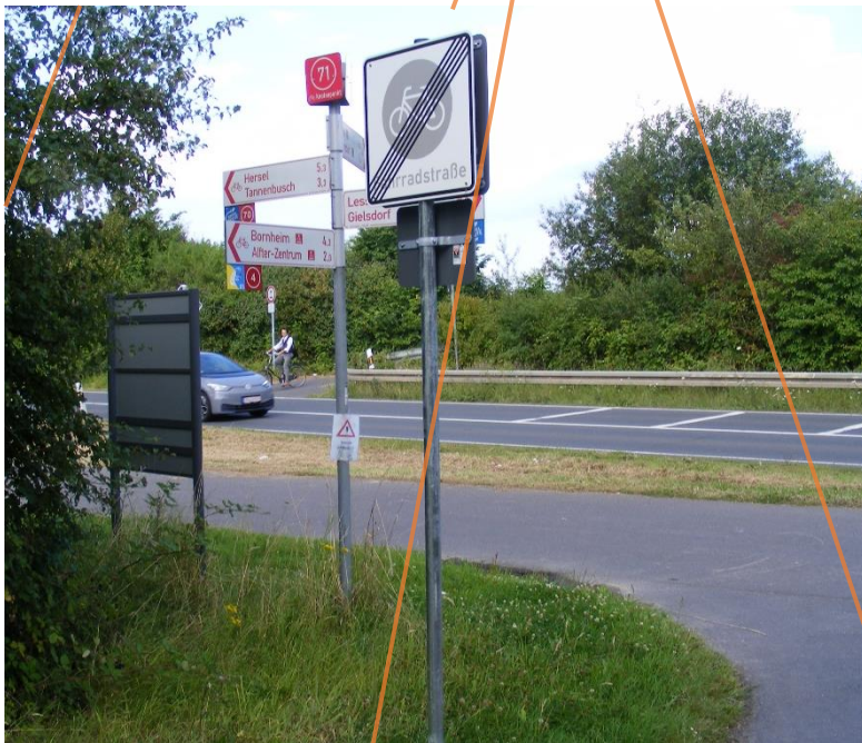
Am Knoten 71 fehlt bislang die Radfahrbrücke über die K 12. Bis sie gebaut ist, muss man die Straße durch oft dichten Autoverkehr dorthin queren, wo der Radfahrer zu sehen ist.
